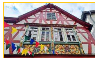
Maison à colombage de Limburg
